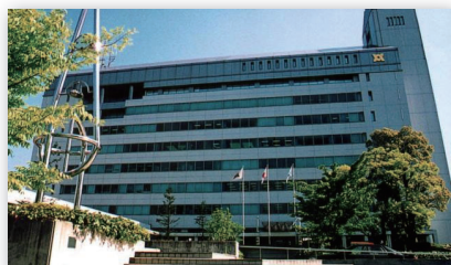
京都府亀岡市役所
